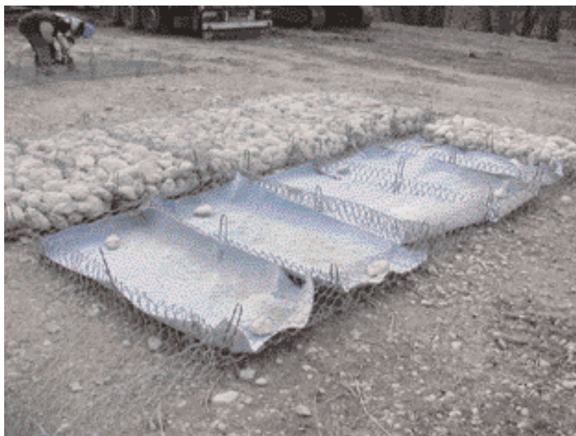
Photo 6 Préparation à terre des matelas Reno Preparing Reno mattresses on land
