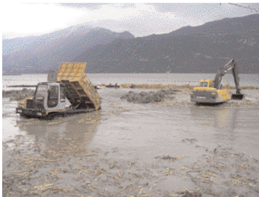
Photo 3 Engraissement à l'arrière des fascines
