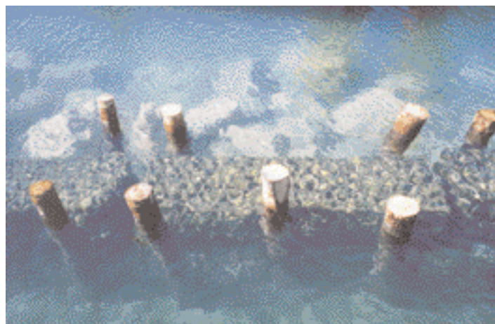
Photo 2 Récifs en gabions maintenus par des pieux en bois
