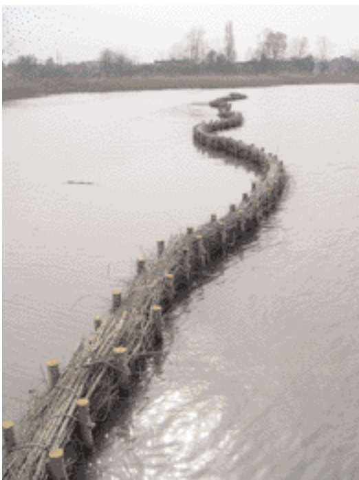
Photo 4 Vue d'ensemble des fascines à l'arrière des récifs en gabions
