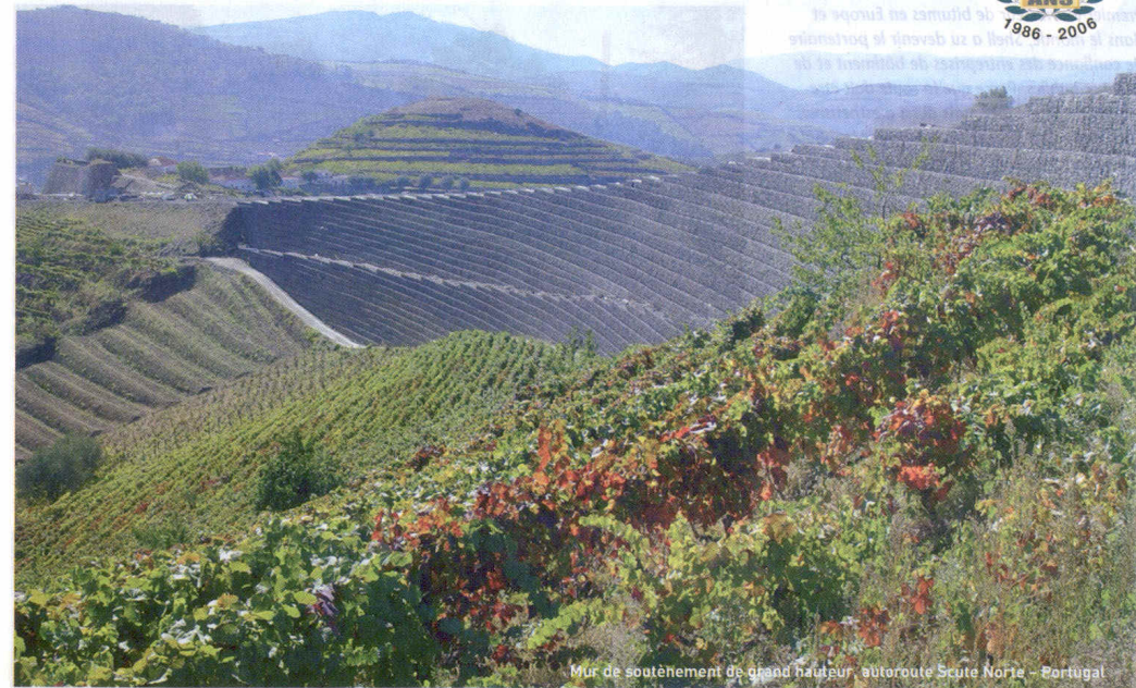
Mur de soutènement de grand hauteur, autoroute Scute Norte - Portugal
