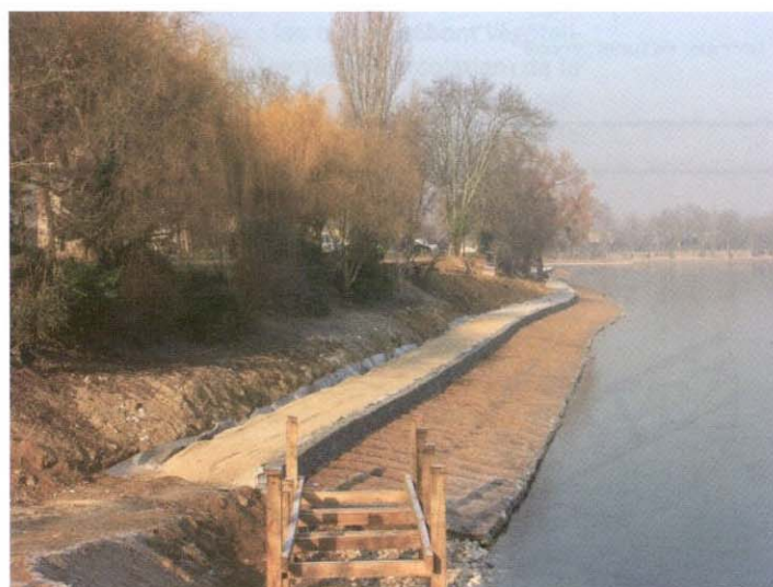
Photo 2 Vue du chantier en fin de travaux
