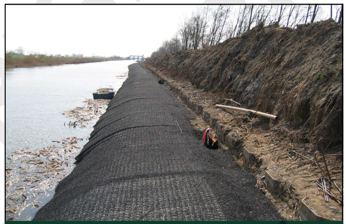
Protection de berge contre l'érosion avec le MacMat
