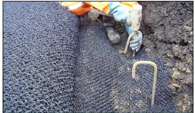
Fixation du MacMat ™ dans la tranchée
